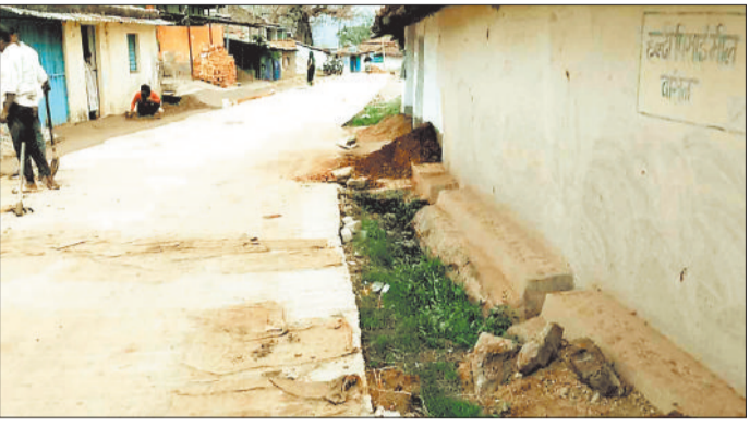
नाली पाटकर सड़क मरमत कर रहे मिस्री।
